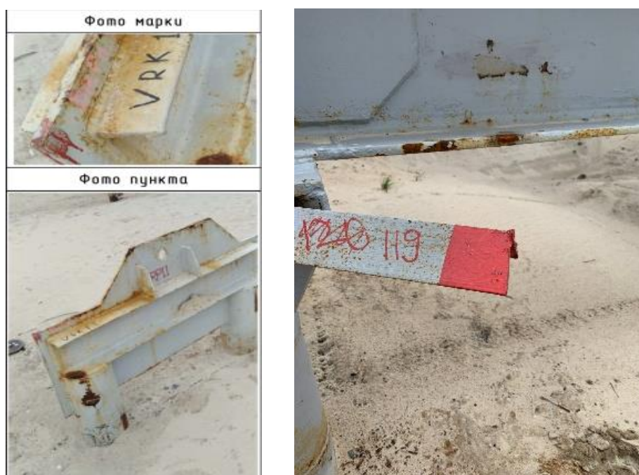
Рисунок 2 – Внешний вид деформационных марок
