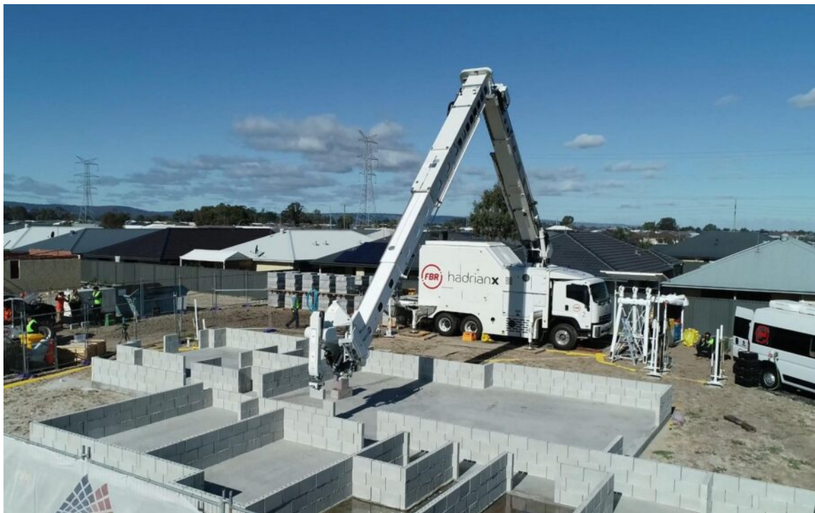
Рис 7. А это австралийский робот-каменщик Hadrian X. Машина кладет до 1000 кирпичей в час. В декабре 2021 года робот строил 16 таунхаусов в местечке Уилладжи в Западной Австралии по заказу местной строительной компании Inspired Homes.
