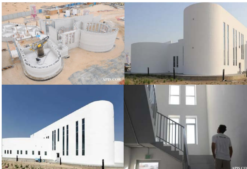
Рис 5. Дом в Дубае стал первой в мире постройкой, которую напечатали на 3D-принтере прямо на стройплощадке. Печать заняла 500 часов, перед ее началом строители сделали две тестовые миниатюры 2 на 2 метра.
